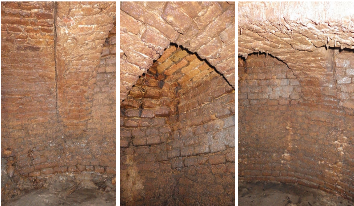
Afbeelding 4.14: de binnenkant van de waterput in westelijke, noordwestelijke en noordelijke richting, met het dichtgezet gat.
