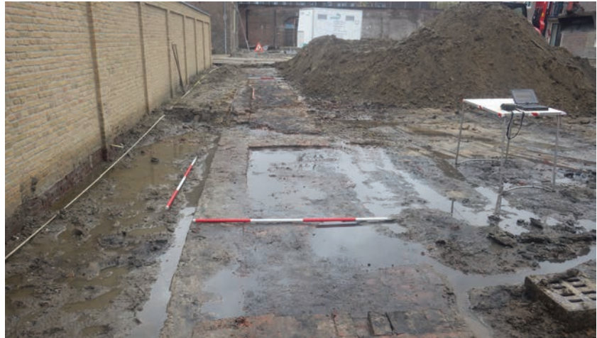
Afbeelding 4.7: plaatfundering van een kogelbak in put 21 (richting west).
